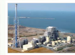
住友金属鹿島火力発電所
